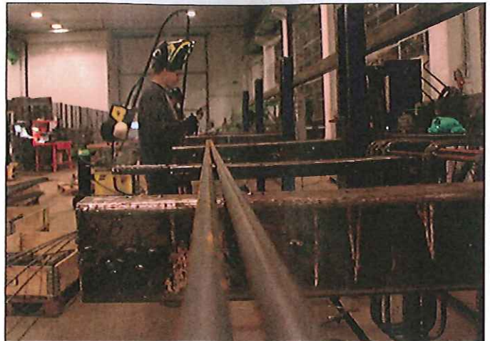
ARMERING. Det går med mange tonn armeringsjern i løpet av et produksjonsår.
